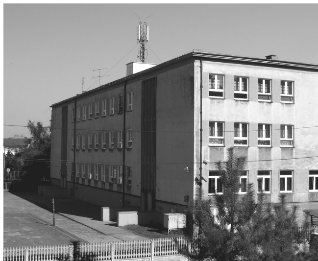
Fot. 1. Budynek szkoły z antenami stacji bazowej.
