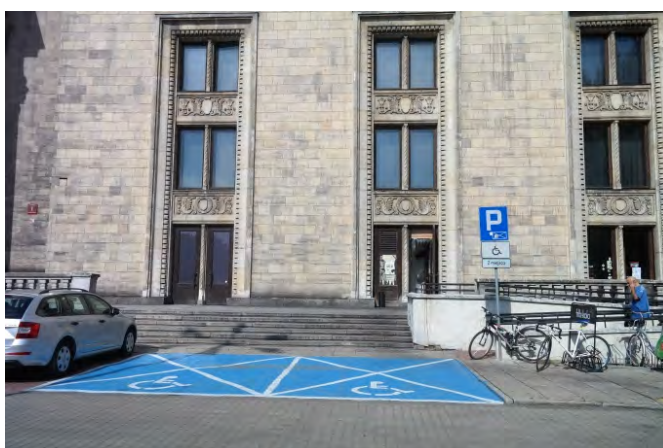
Zdj. 02, 03 Miejsca parkingowe dla osób z niepełnosprawnością w otoczeniu zabytkowego PKiN w Warszawie, nawierzchnia z kostki brukowej
