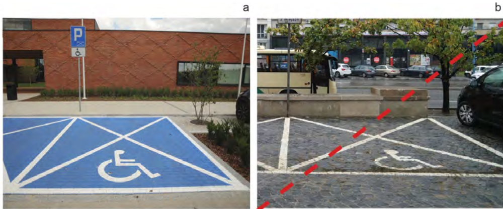
Zdj. 01 Nawierzchnia miejsca postojowego dla osób z niepełnosprawnością zdj. a: równa i gładka kostka betonowa – zalecana, zdj. b: bruk kamienny - rozwiązanie niepoprawne
