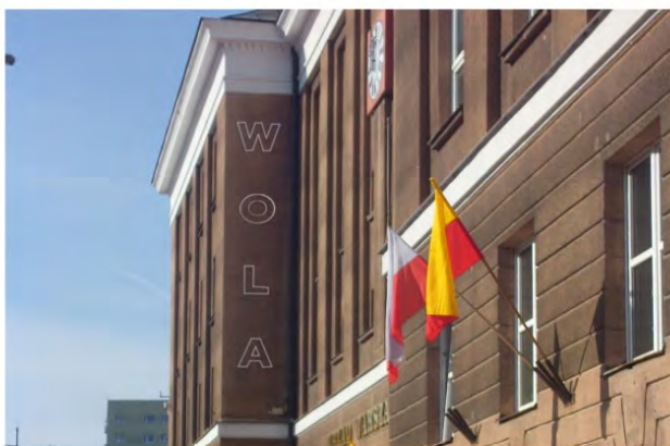
Neon na fasadzie głównej wspomagający identyfikację obiektu
