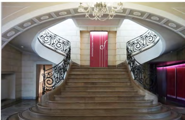
Stopnie schodów znaczone ciemnymi, kontrastującymi taśmami
